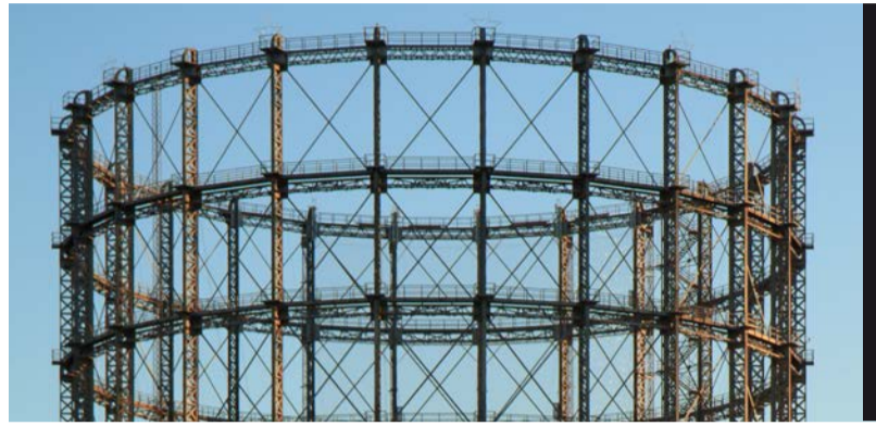
Der Gasometer: Landmarke des EUREF-Geländes (Foto: Wiki-Commons)
